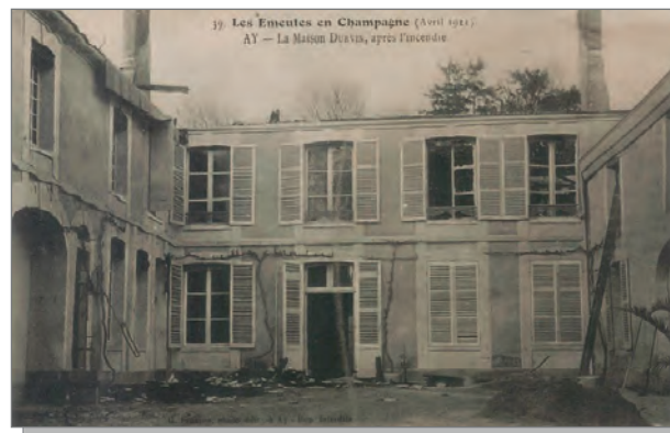
Les restes de la Maison Durvin après l'incendie.
