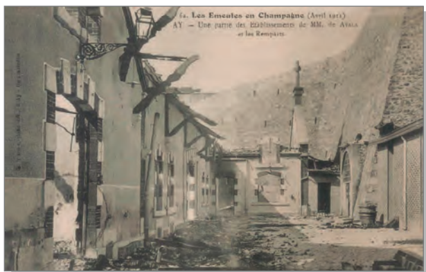
Une partie de la Maison Ayala incendiée.
