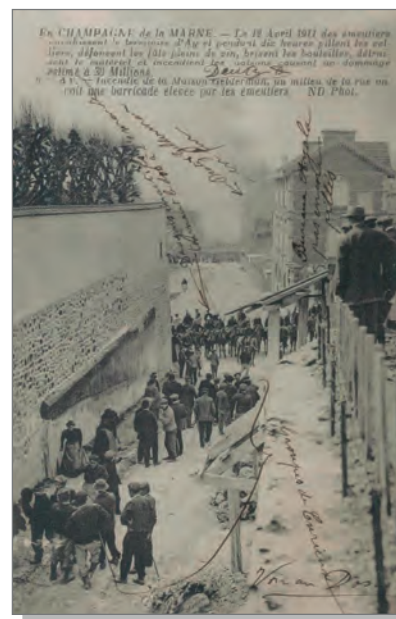
Ay - Incendie de la Maison Geldermann.
