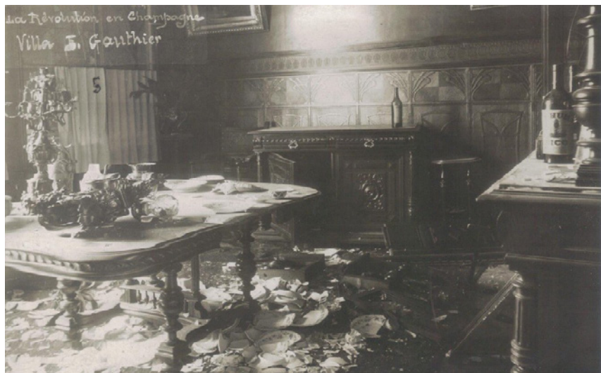
Photo 9. La Maison Gauthier dévastée.
